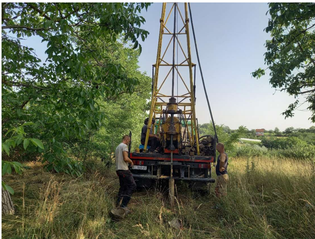
Слика 4: Истражно бушење за потребе трасе пута
